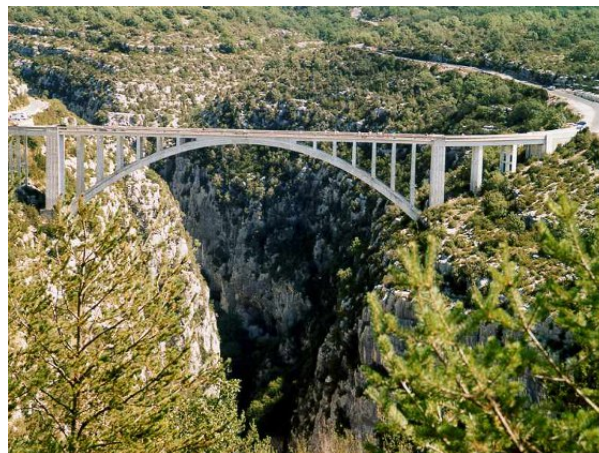
Pont de l'Artuby.
